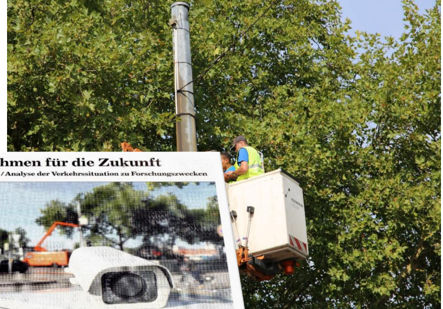
3-D-KARTEN ERSTELLEN UND VERKEHRSTEILNEHMER BESTIMMEN: Diese Aufgaben erledigt eine Kamera die seit gestern als erste für das „Testfeld Autonomes Fahren“ in der Durlacher Allee hängt. Foto: Sandbille
